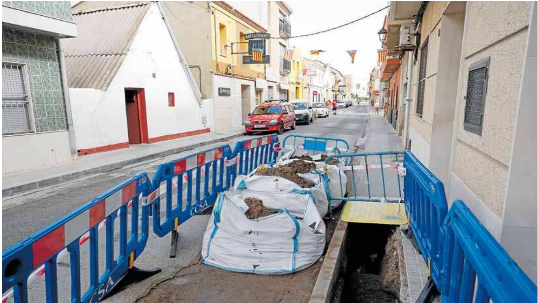
Obras de reparación de las cañerías afectadas en El Palmar, este lunes. JESÚS SIGNES
